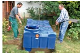
3. plaats de Flatline-(filter)tank
