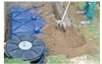
4. graaf de tank in
